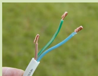
Εικόνα 1- 44: Ετοιμασία των άκρων των καλωδίων
