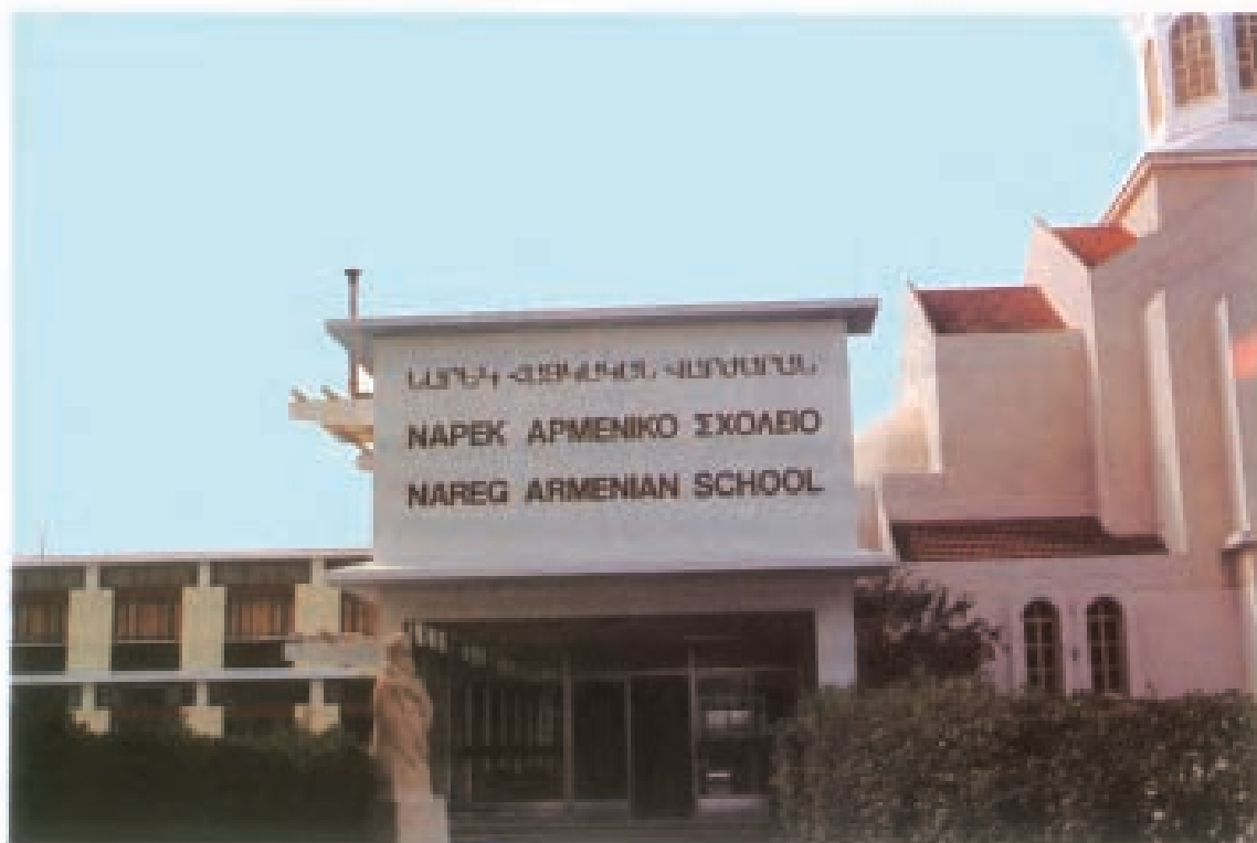
Το αρμενικό δημοτικό σχολείο Ναρέκ στη Λευκωσία
