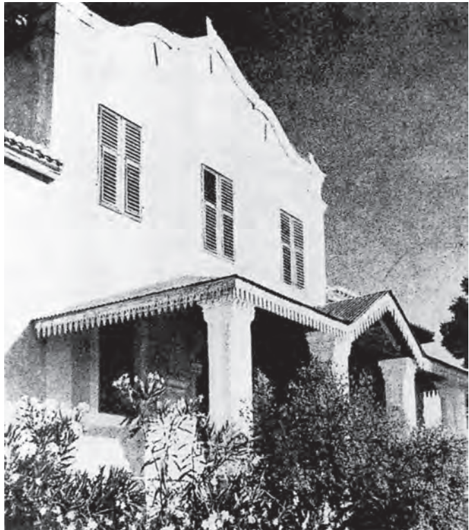
Το σπίτι του Σολωμού στη Ζάκυνθο, πριν καταστραφεί εντελώς από τους σεισμούς του 1953
