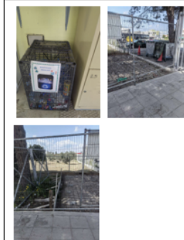
Εικόνα 4-5-6: [Κατασκευή προστατευμένου χώρου για την τοποθέτηση μεγάλων κάδων ανακύκλωσης - Κατασκευή πλαστικών δοχείων για την συλλογή των άδων πλαστικών μπουκαλιών]
