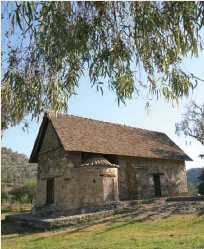
77. Παναγία της Ασίνου (μονόχωρος καμαροσκέπαστος ναός), Νικητάρι, 1105/1106, νοτιοδυτική άποψη. Η ξύλινη στέγη που καλύπτει την καμαροσσεπή είναι μεταγενέστερη προσθήκη.
