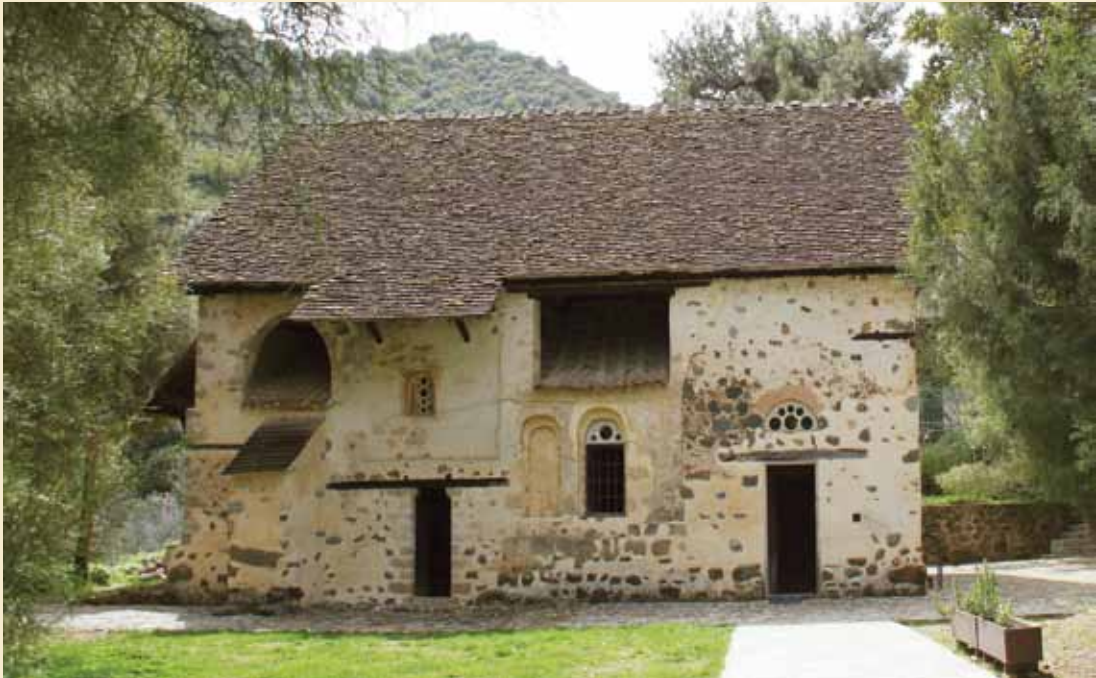
68. Άγιος Νικόλαος της Στέγης (σταυροειδής εγγεγραμμένος ναός με τρούλο), Κακοπετριά, 11ος αιώνας, βόρεια άποψη. Η ξύλινη στέγη που καλύπτει το ναό και τον τρούλο του είναι μεταγενέστερη προσθήκη (τέλη 12ου – αρχές 13ου αιώνα).
