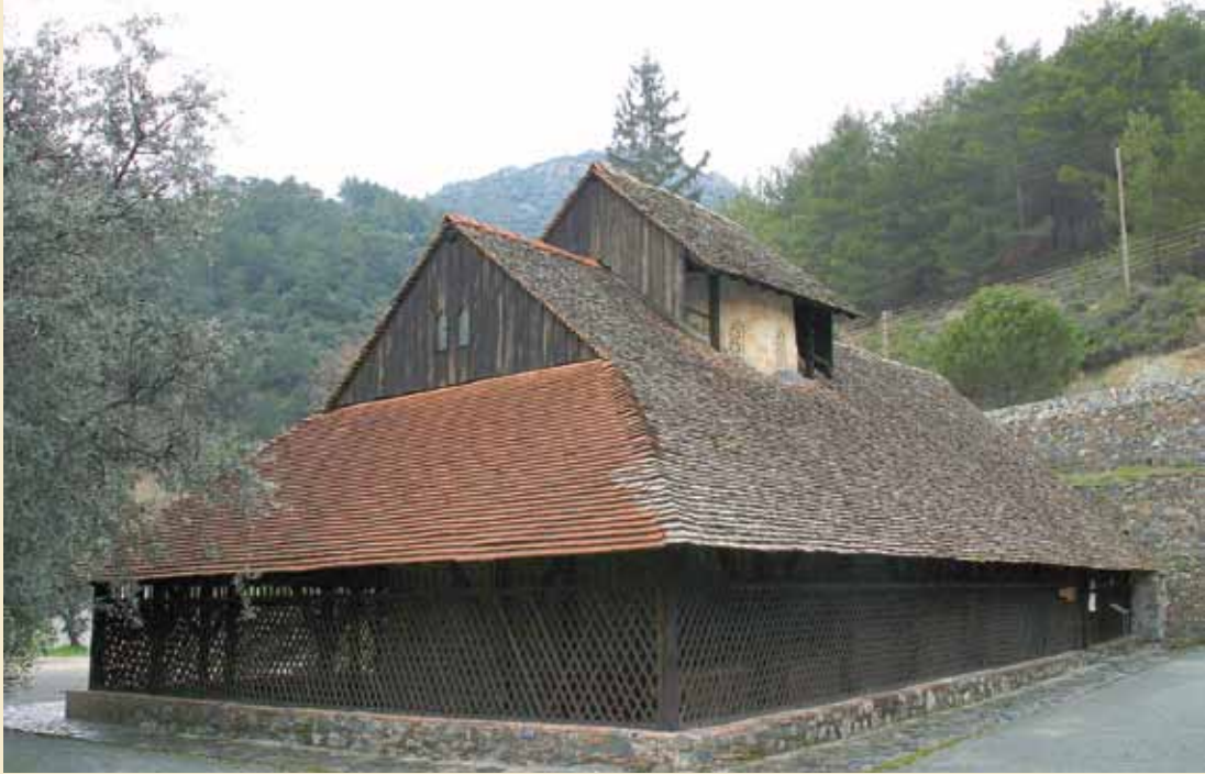
75. Παναγία του Άρακα (μονόχωρος ναός με τρούλο), Λαγουδερά, 12ος αιώνας, βορειοανατολική άποψη. Η ξύλινη στέγη που καλύπτει το ναό και τον τρούλο του είναι μεταγενέστερη προσθήκη.
