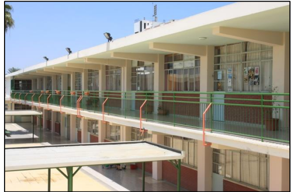
Οι αίθουσες του σχολείου που φαίνονται στη φωτογραφία είναι κτισμένες .....
