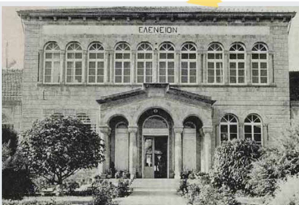
Φωτογραφία πρόσοψης Ελένιου Δημοτικού Σχολείου (άγνωστη ημερομηνία λήψης). Πηγή: Ιστοσελίδα Άλλη Κύπρος http://allikypros.wordpress.com
