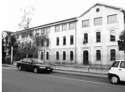
Figure 18. The Istituto Comprensivo building in Paesana
